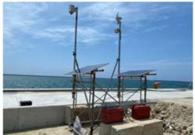
足場に組み付けて設置した事例
