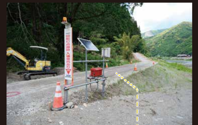
③ 受信機が信号を受信 ④ 回転灯が一定時間作動 ※ 車両通過の所要時間に合わせてタイマー設定が可能です。
