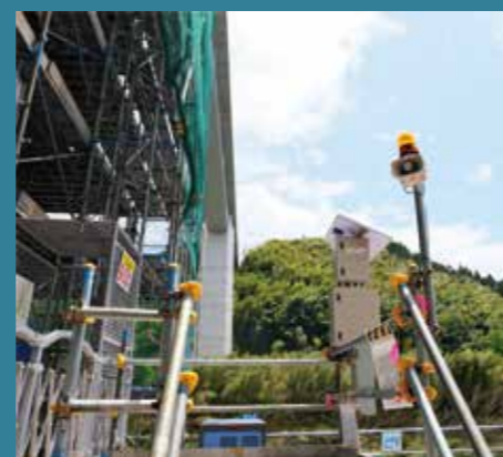
③ 受信機が信号を受信 ④ 回転灯とブザーが作動
