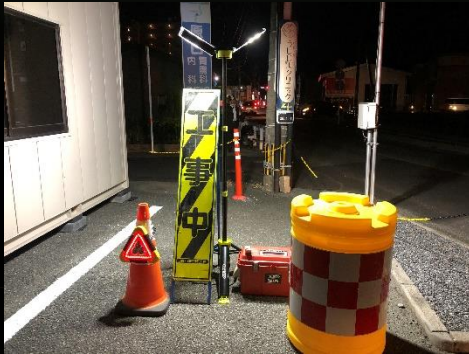
▲夜間工事で作業箇所の照明として使用
