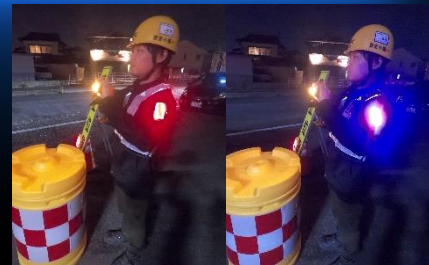
▶夜間工事で誘導員の安全確保に使用
